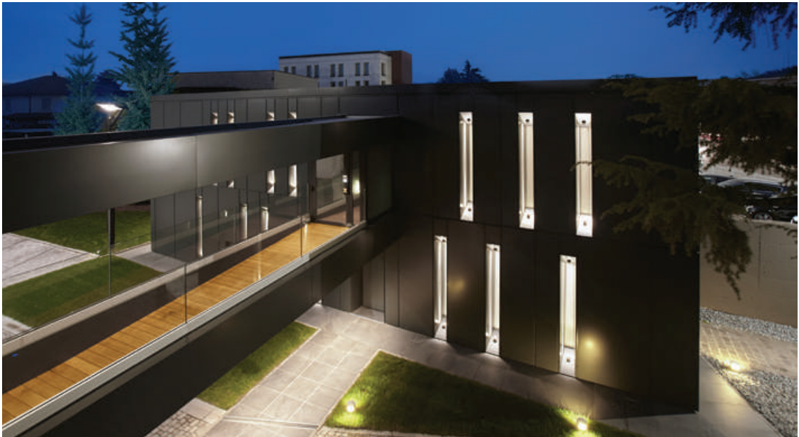
Parte della sede VCB Securitas di Brescia con l'ARC, Alarm Receiving Centre
